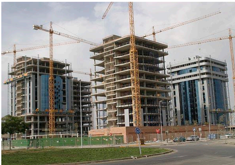
Figura 12. Edificios residenciales en construcción [Diario El País, Cali Colombia]
